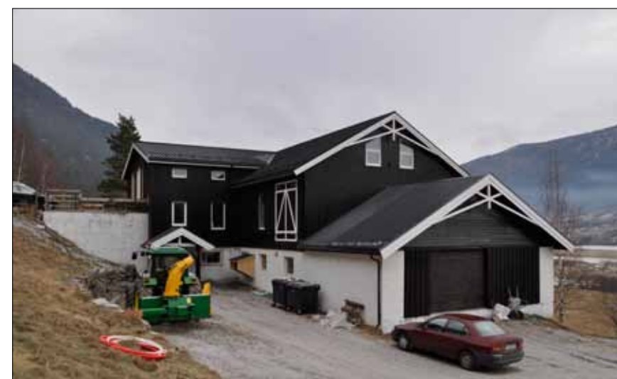
OMBYGD LÅVE: Lom Bryggeri held til i den ombygde låven i Grjotheim i Lia. Her er det bryggerihall, lager og etterkvart kurs- og serveringslokale.
